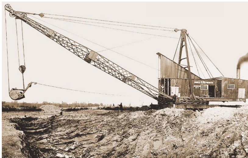
Obr. 27 Heyworthove rýpadlo pri hĺbení kanála, Chicago [8]
