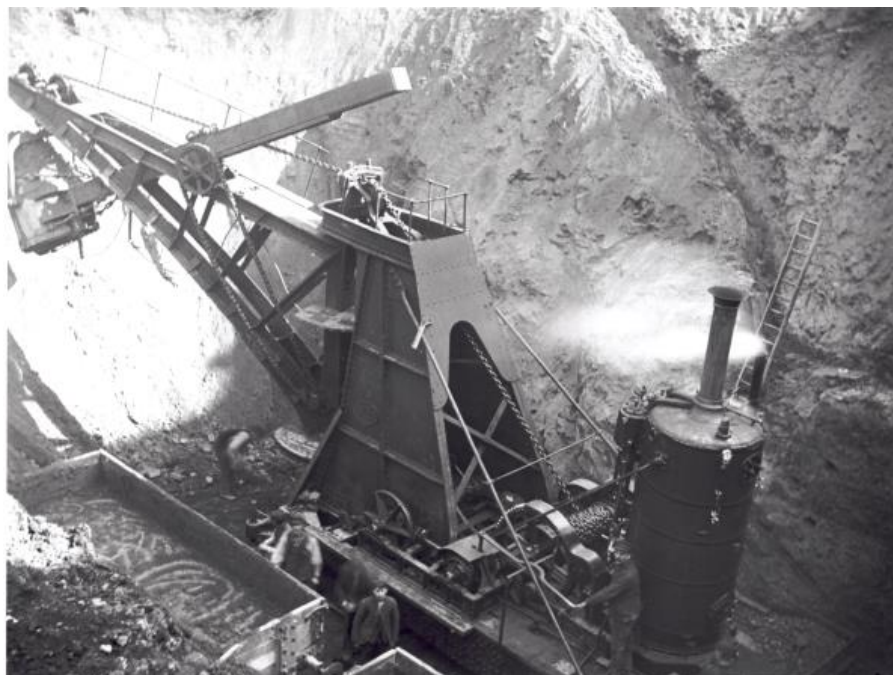
Obr. 5 Rustnovo rýpadlo s charakteristickou mohutnou vežou [6]
