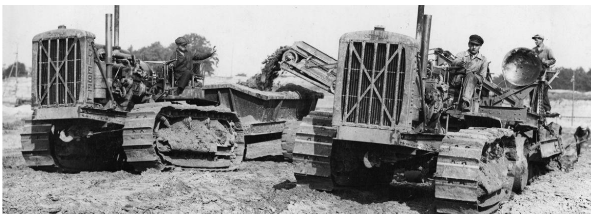
Obr. 34 Legendárne Caterpillar D8 ťahajúce prvé skrejpre [47]
