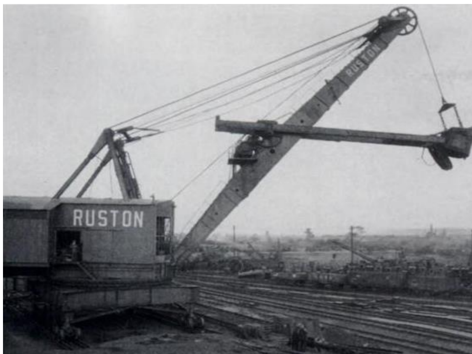
Obr. 19 Ruston No.300 prechádza testami v továrni v Lincolne
