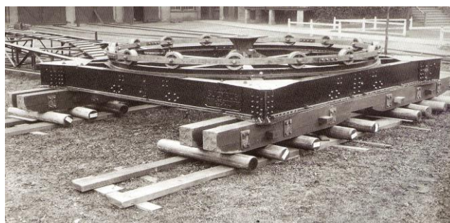
Obr. 28 Jediný variant pohybu pre Bucyrus bol po guľatinách na trámoch [2]
