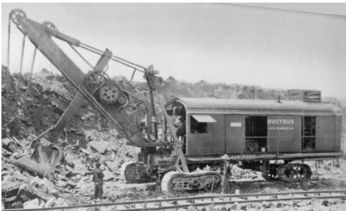
Obr. 20 Rýpadlo Bucyrus po inštalácii prechodového pásového balíčka
